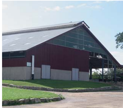
De nya ladugårdarna på Wapnö byggs luftiga, ljusa med öppen nock och självventilation.
